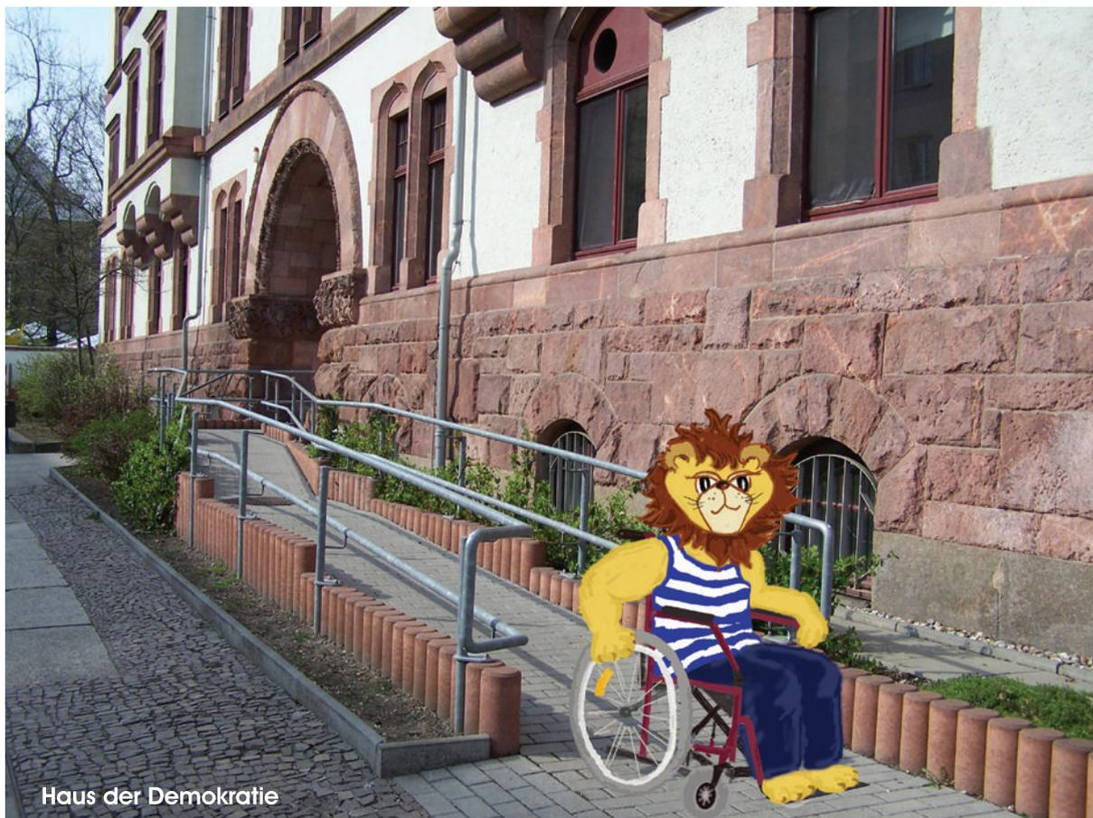
Die Rampe wurde an der Seite angebaut. Sie ist lang und hat in der Mitte ein Stück flache Strecke. Dadurch kann ich beim Hinauffahren ausruhen und nach unten wird es nicht zu schnell.
