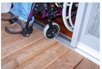
F123: Überwinden der Balkonschwelle mittels Klapprampe (Wohnungsanpassungsmaßnahme)
