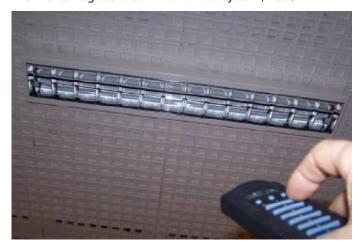
F29: Lichtanlage schalten mit Funkbussystem, EIN / AUS
