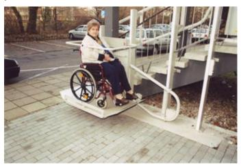
Neben dem Plattformlift gibt es als weitere Möglichkeiten die technische Lösung über eine Hebebühne für Personenbeförderung mit einer maximale Förderhöhe bis ca. FH = 1,60 m. Dieser Fall ist preiswerter als die Aufzugsvariante. Bei einer genügend großen Personenplattform am Haupteingang des Hauses kann diese Hebebühne senkrecht neben den Treppenlauf installiert werden.
